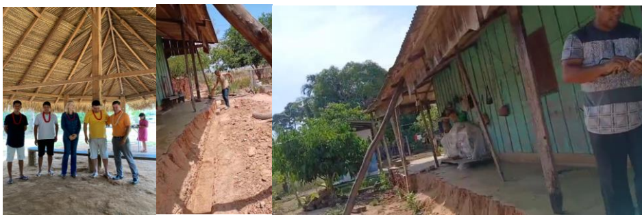
Serviço voluntário carpintaria e alvenaria de restauração de residência na área indígena de 22/12/2025 é da área lá da Mariana
