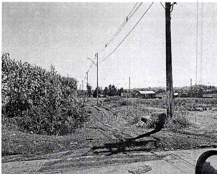
Foto 01 – Rua Projetada “A”.
