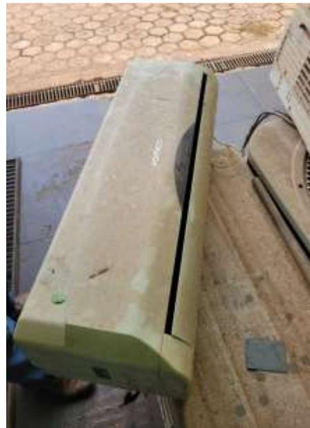
**Justificativa para desfazimento:** ativo não utilizado; placa eletrônica queimada; custo para substituição de peça inviável; equipamento já substituído.
