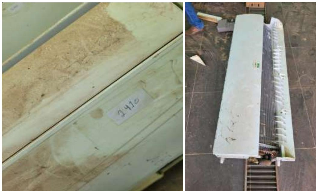
**Justificativa para desfazimento:** ativo não utilizado; placa eletrônica queimada; custo para substituição de peça inviável; equipamento já substituído.
