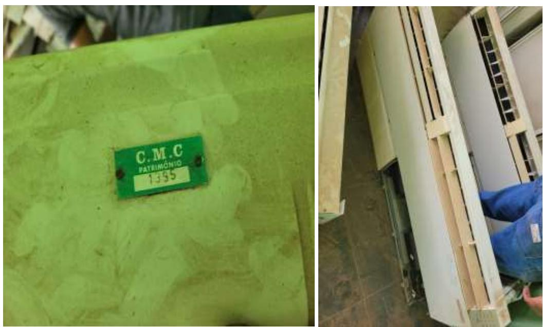
**Justificativa para desfazimento:** ativo não utilizado; compressor queimado; custo para substituição de peça inviável; equipamento já substituído.
