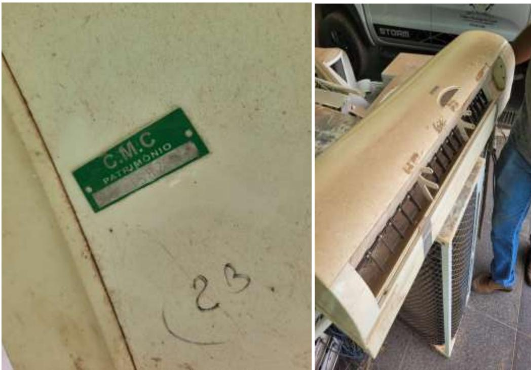
**Justificativa para desfazimento:** ativo não utilizado; compressor queimado; custo para substituição de peça inviável; equipamento já substituído.
