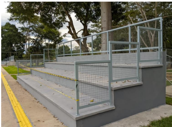
Descrição: GUARDA-CORPO DE AÇO
