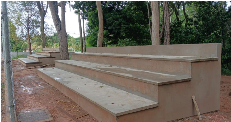
Descrição: ARQUIBANCADAS DA QUADRA DE AREIA COM PISO= 1M, ESPELHO=44CM, LARGURA= 8,90M
