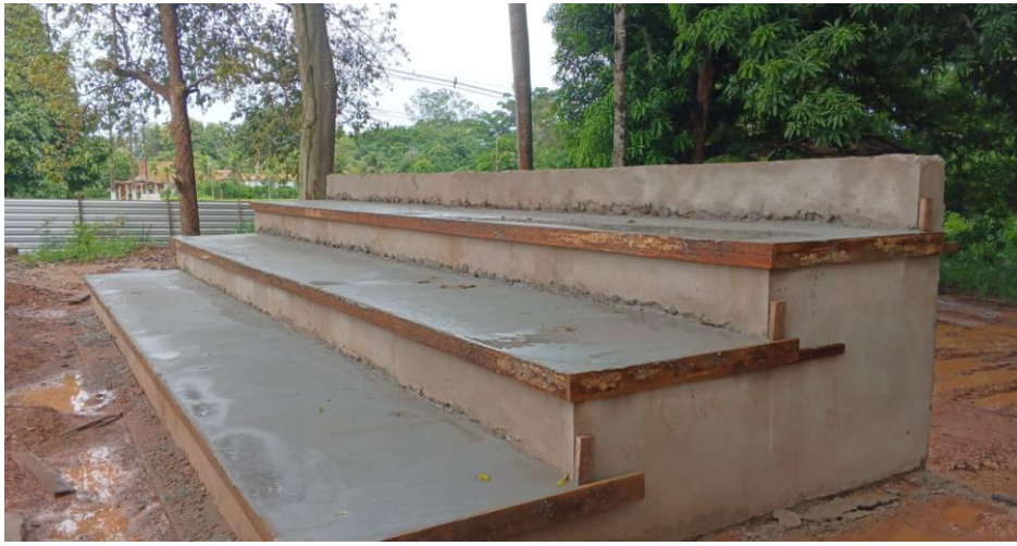
Descrição: ARQUIBANCADA DA QUADRA DE AREIA COM PISO= 1M, ESPELHO=44CM, LARGURA= 8,90M
