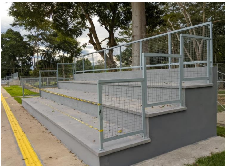
Descrição: GUARDA-CORPO DE AÇO
