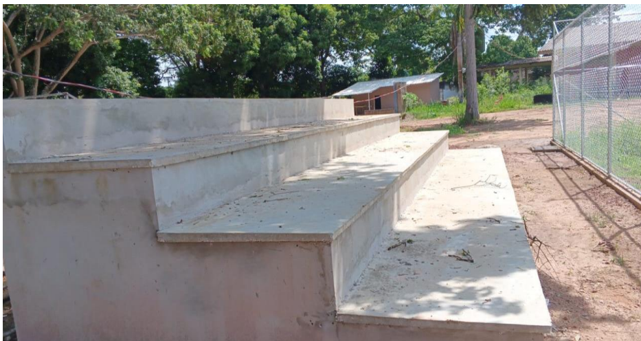
Descrição: ARQUIBANCADA DO CAMPO DE FUTEBOL COM PISO= 1M, ESPELHO=44CM, LARGURA= 8,90M
