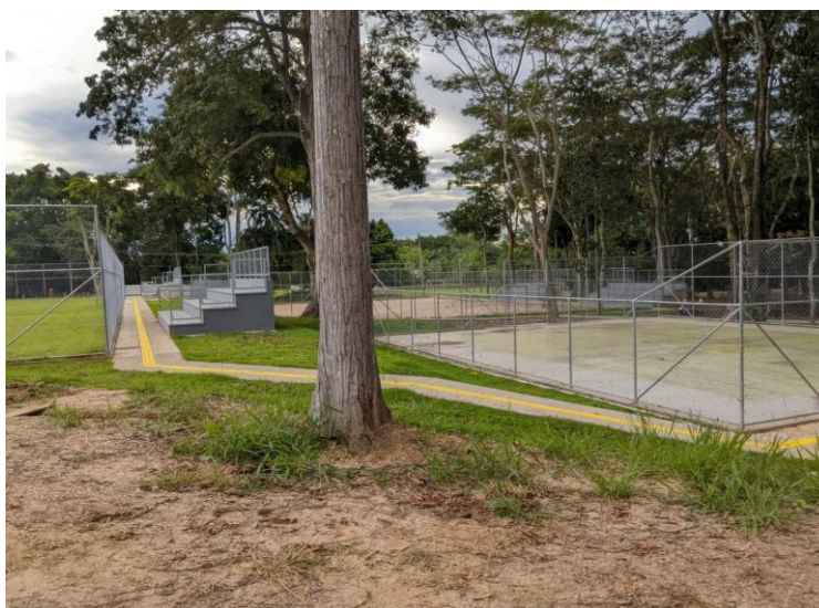
Descrição: EXECUÇÃO DE PASSEIO (CALÇADA) OU PISO DE CONCRETO COM CONCRETO MOLDADO IN LOCO, USINADO, ACABAMENTO CONVENCIONAL, NÃO ARMADO. AF_07/2016
