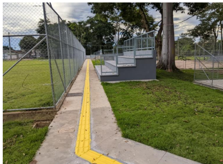
Descrição: PINTURA DE PISO COM TINTA ACRÍLICA
