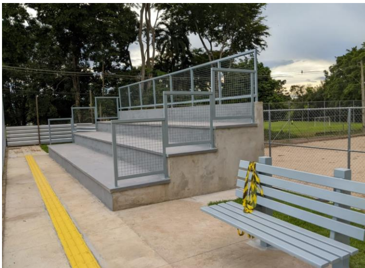
Descrição: PISO TÁTIL ALERTA OU DIRECIONAL
