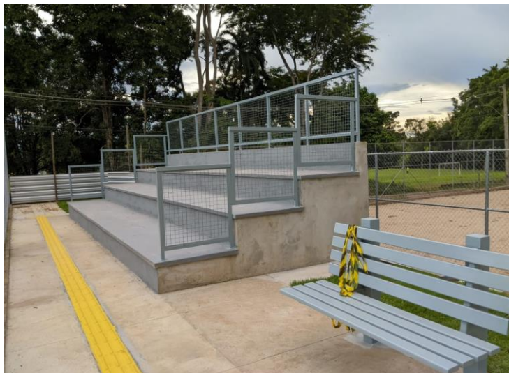
Descrição: PISO TÁTIL ALERTA OU DIRECIONAL
