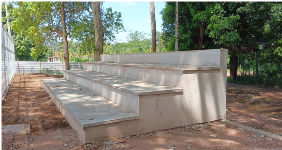
Descrição: ARQUIBANCADA DA QUADRA DE AREIA COM PISO= 1M, ESPELHO=44CM, LARGURA= 8,90M
