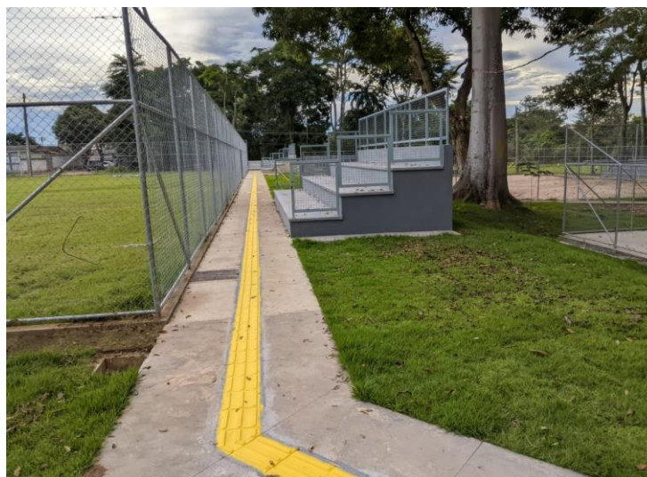
Descrição: PINTURA DE PISO COM TINTA ACRÍLICA
